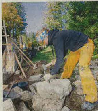
Les bénévoles ont terminé la rénovation d'un mur de pierres sèches. MURIEL ANTILLE
