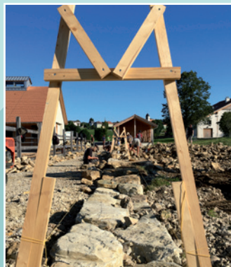
Semaine mur de pierres sèches
