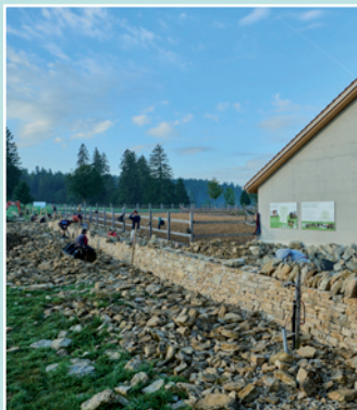
Semaine mur de pierres sèches
