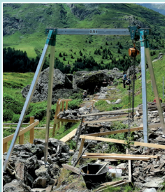
Semaine mur de pierres sèches
