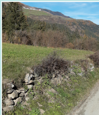
Semaine mur de pierres sèches
