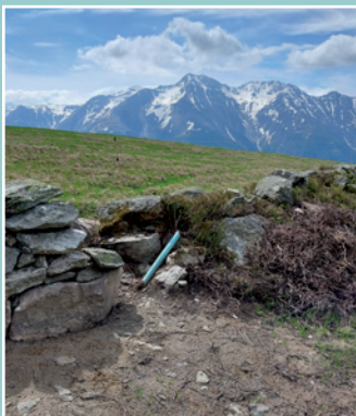
Semaine mur de pierres sèches
