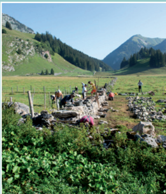
Semaine mur de pierres sèches
