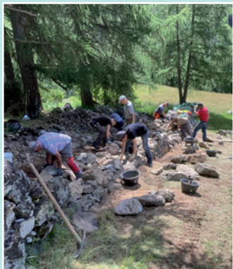
Semaine mur de pierres sèches
