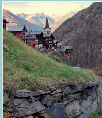
Semaine mur de pierres sèches
