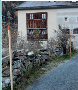
Semaine mur de pierres sèches
