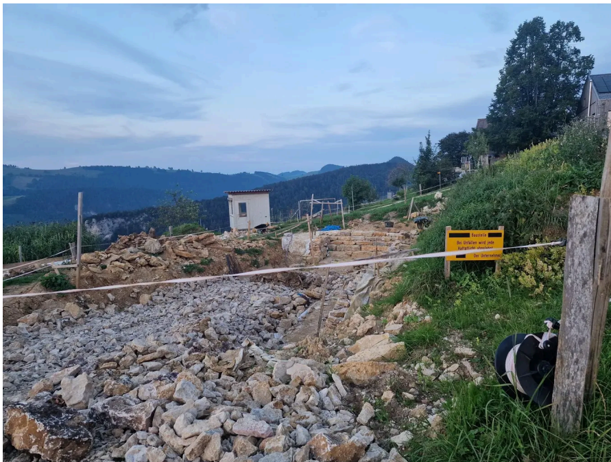
Die Baustelle beim Gasthaus Probstenberg im August 2024.
