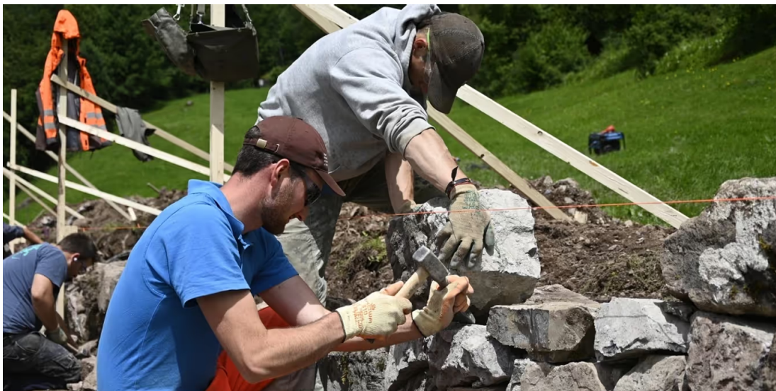
Sanierung von Trockenmauern in Ennenda - Stiftung Umwelteinsatz
