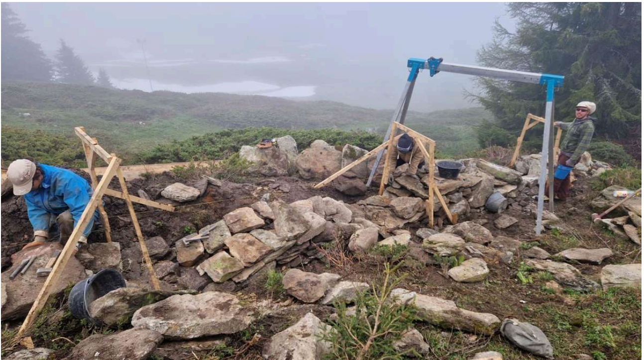
Zivildienstleistende sanieren auf der Riederalp eine beschädigte Trockenmauer. Quelle: Stiftung Umwelteinsatz
