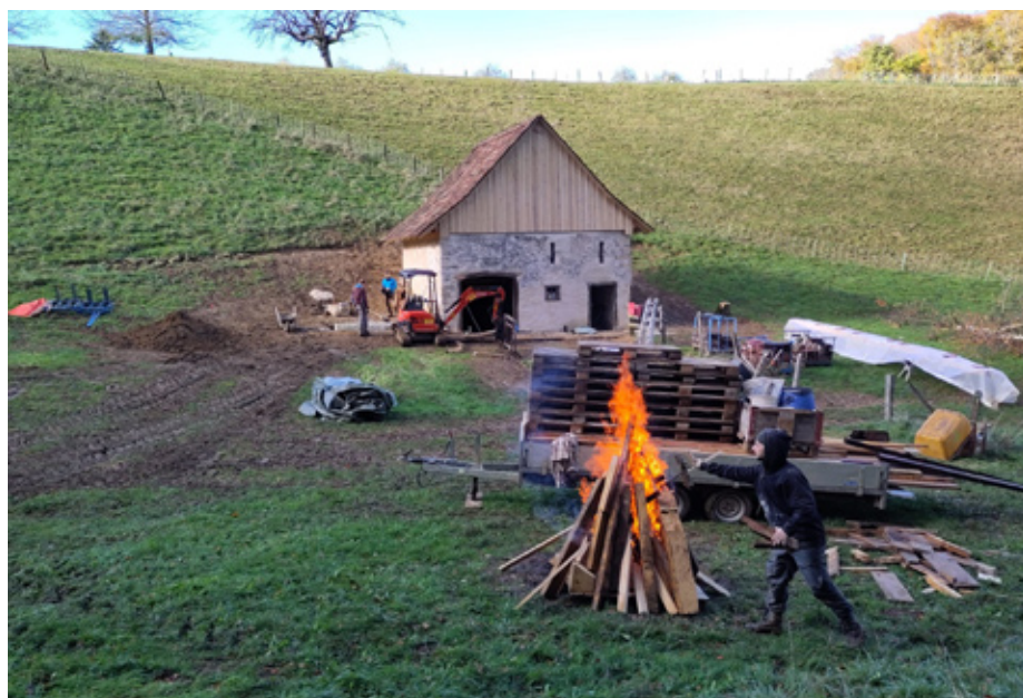
Sanierung einer Feldscheune in Ziefen.
