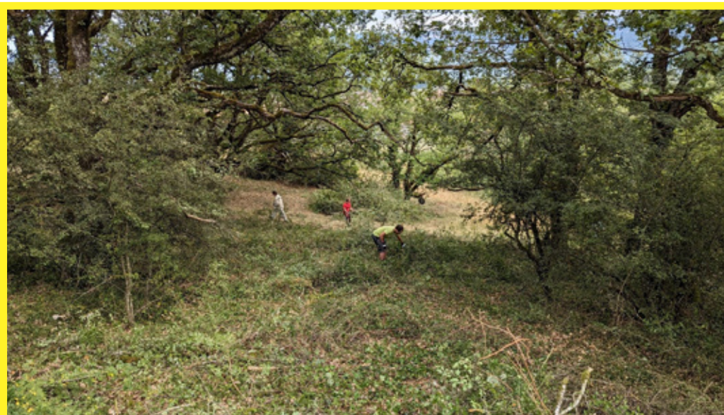
Entbuschungsarbeiten im TWW La Chassagne, Onnens.
