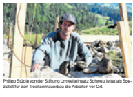
Philipp Städele von der Stiftung Umweltschutz Schweiz ist als Koordinator für den Trockenmauerbau die Arbeiten vor Ort.
