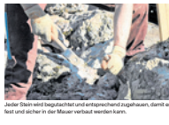
Jeder Stein wird begründet und entsprechend zusammengebaut, damit er sicher in der Mauer verankert werden kann.
