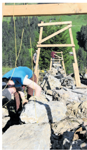
Insgesamt werden im Gebiet Rütli 225 Meter Trockenmauer saniert.
