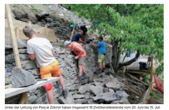
Unter der Leitung von Pascal Zorist haben insgesamt 18 Zivildienstleistende vom 20. Juni bis 15. Juli 70 Quadratmeter stark beschädigte Trockenmauern in Randa saniert.
