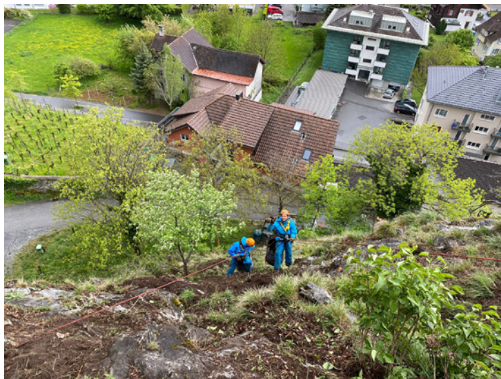
Auspickeln von Flieder, gesichert am Seil, am steilen Schlosshügel in Sargans.
