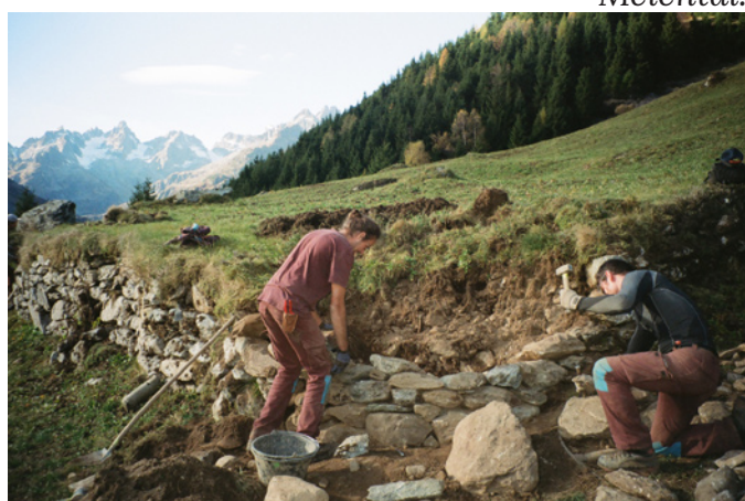
Sanierung von Trockenmauern im Meiental.
