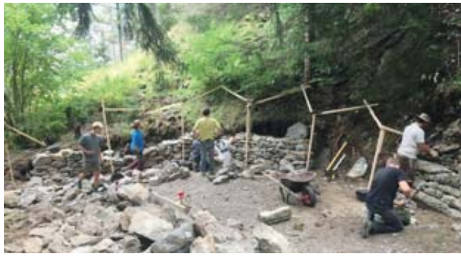
Les travaux de remise en état des murs en pierres sèches ont été réalisés par la Fondation Actions Environnement. LDD
