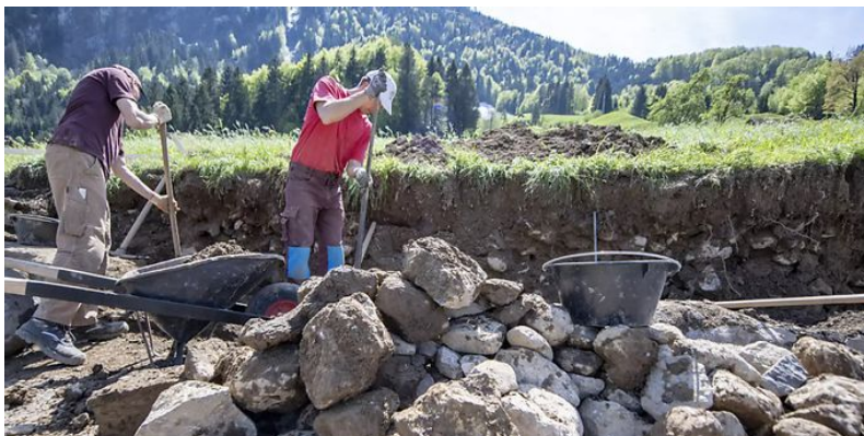
Zivis arbeiten an der Sanierung einer Trockenmauer. (Archivbild) - sda - KEYSTONE/URS FLUEELER
