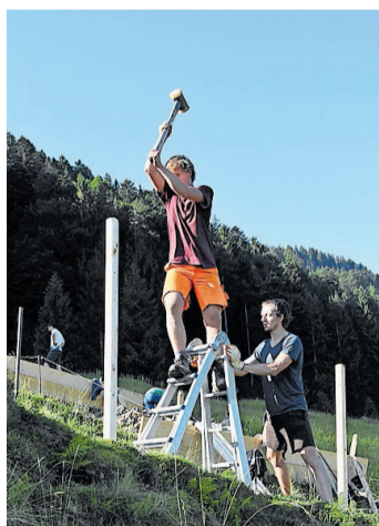
Helfer schlagen Pfosten für ein Sicherheitsnetz ein.
