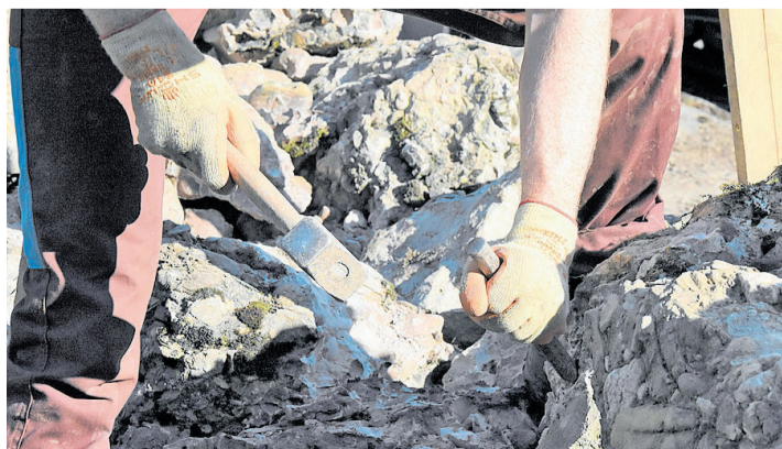
Jeder Stein wird begutachtet und entsprechend zugehauen, damit er fest und sicher in der Mauer verbaut werden kann.
