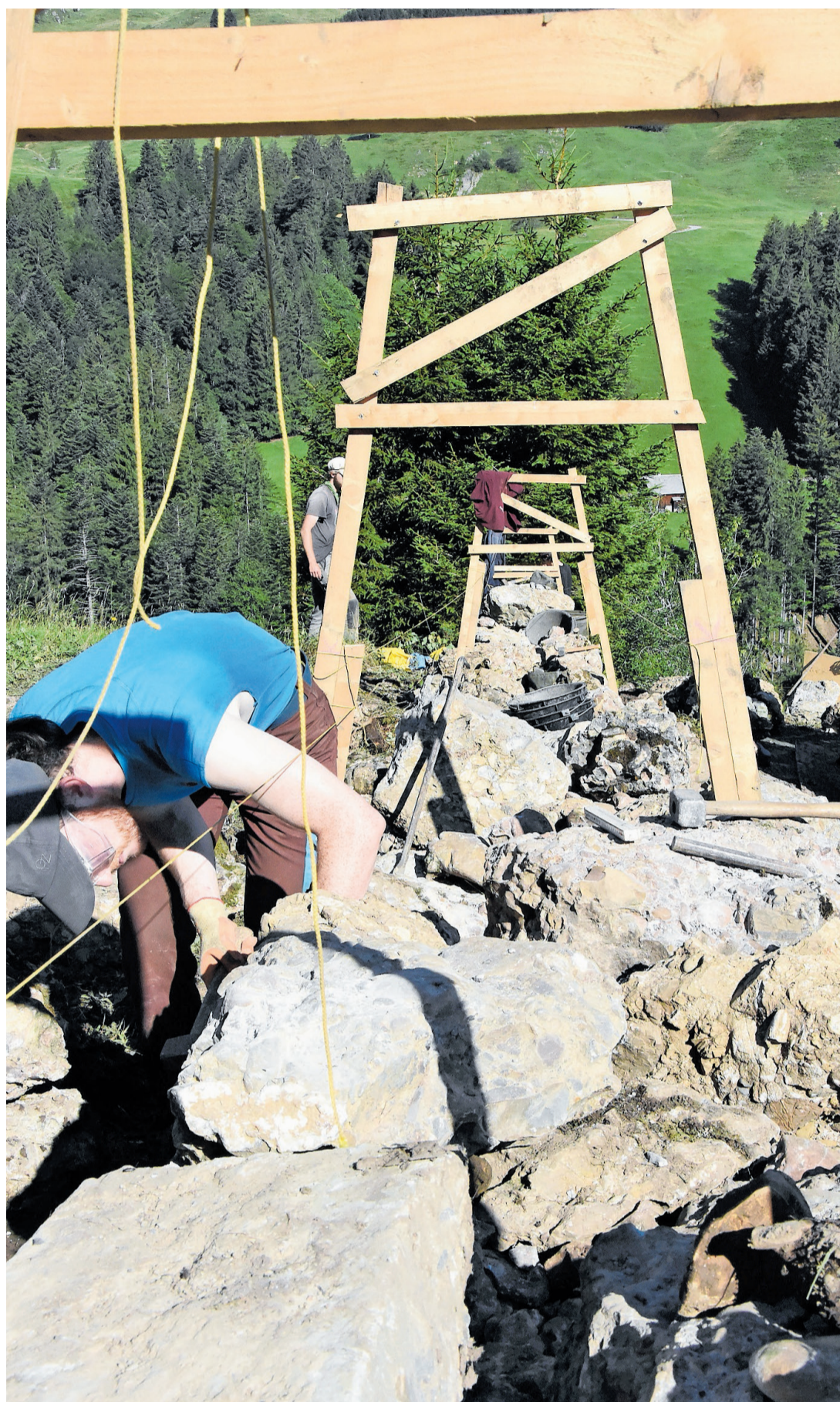
Insgesamt werden im Gebiet Rüti 225 Meter Trockenmauer saniert.
