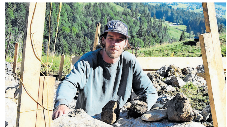
Philipp Stüdle von der Stiftung Umwelteinsatz Schweiz leitet als Spezialist für den Trockenmauerbau die Arbeiten vor Ort.
