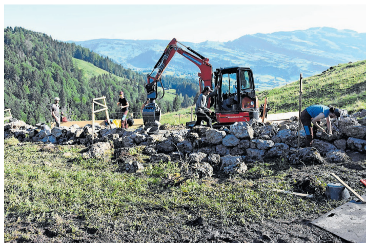
Um die Nagelfluhbrocken für die Trockenmauer zu bewegen, ist teils schweres Gerät nötig.
