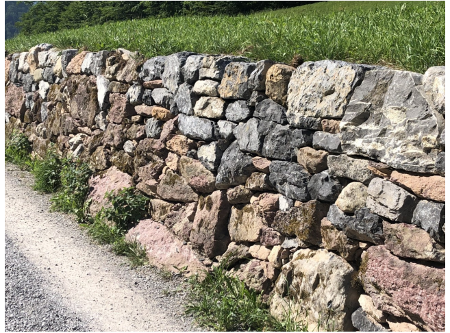
Neu sanierte Trockenmauer, Steingefüge mit Öffnungen für kleine Tiere und Pflanzen (Bilder: zvg)
