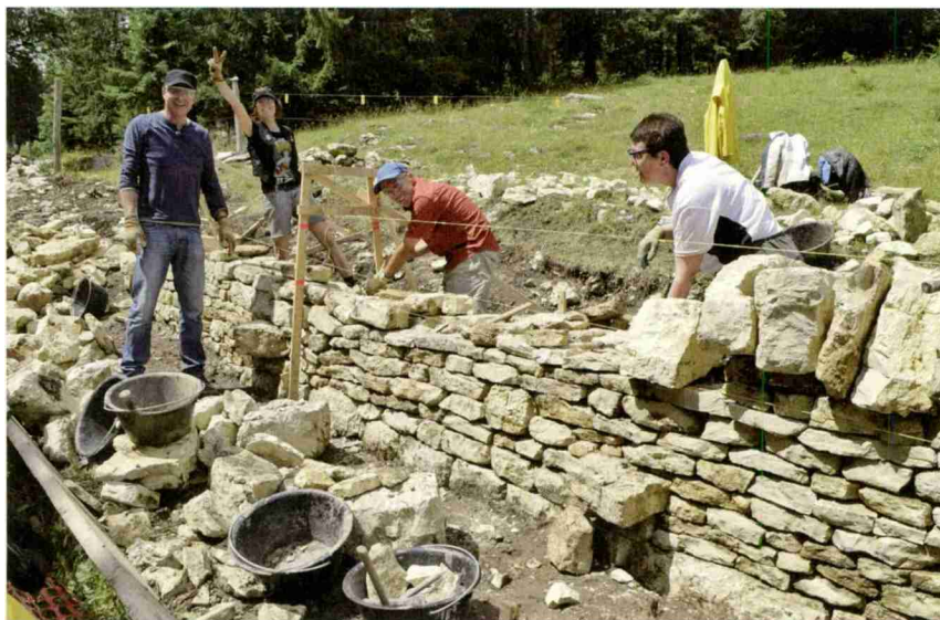
Wiederaufbau einer freistehenden Trockenmauer in La Sagne im Kanton Neuenburg. Foto: Stiftung Umwelteinsatz Schweiz.
