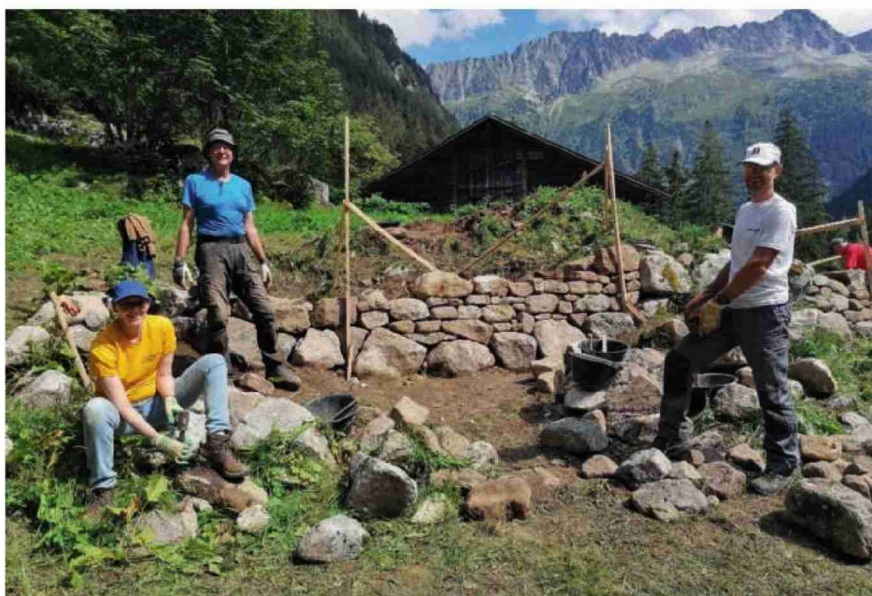
Photo du haut: épierrage et travaux d'entretien sur les prairies d'alpage de l'Alp Penära (SG); Photo du bas: réfection d'un mur de pierres sèches dans la vallée de Meien (UR).
