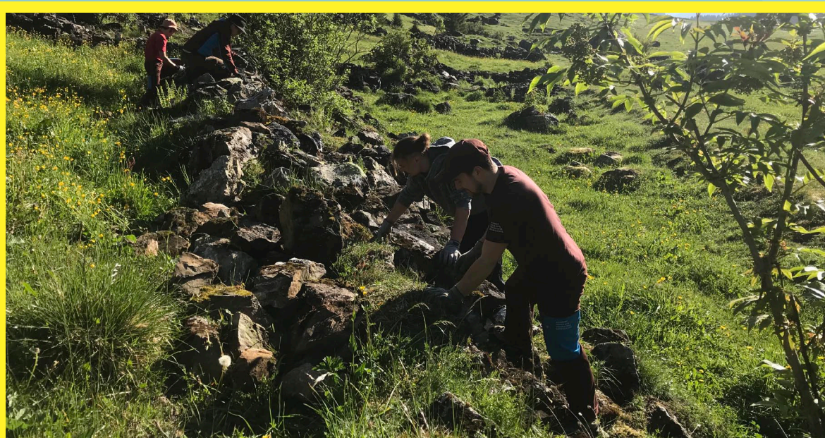
Wiederaufbau von alten Trockenwällen auf dem Urnerboden.
