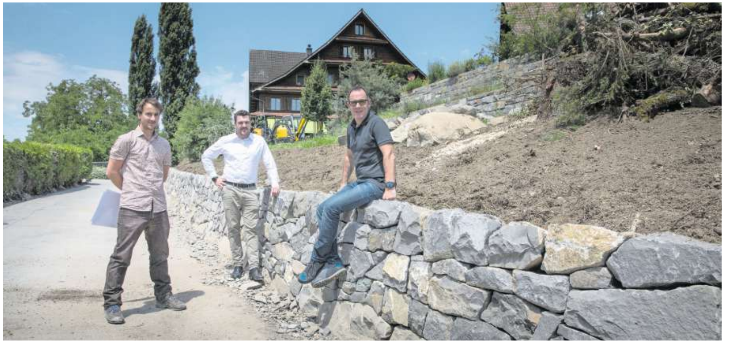
Frisch vollendet: die 100 Meter lange Trockensteinmauer an der Höfenstrasse. Von links: Projektleiter Stefan Rey, der Zuger Bauchef Florian Weber und Grundstückseigentümer Beda Schlumpf. Bild: Matthias Jurt (Steinhausen, 26. Juni 2020)
