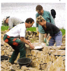
Während vier Jahren bauten viele Freiwillige ein langes Stück der alten Trockensteinmauer auf dem Probstenberg wieder auf.
