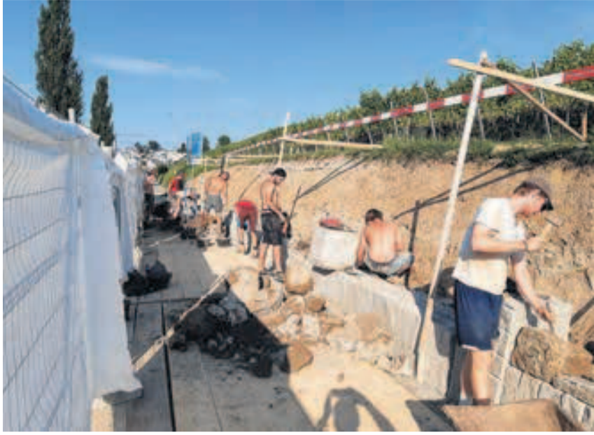
Die Zivildienstleistenden starten mit viel Elan in den Bau der Trockenmauern.
