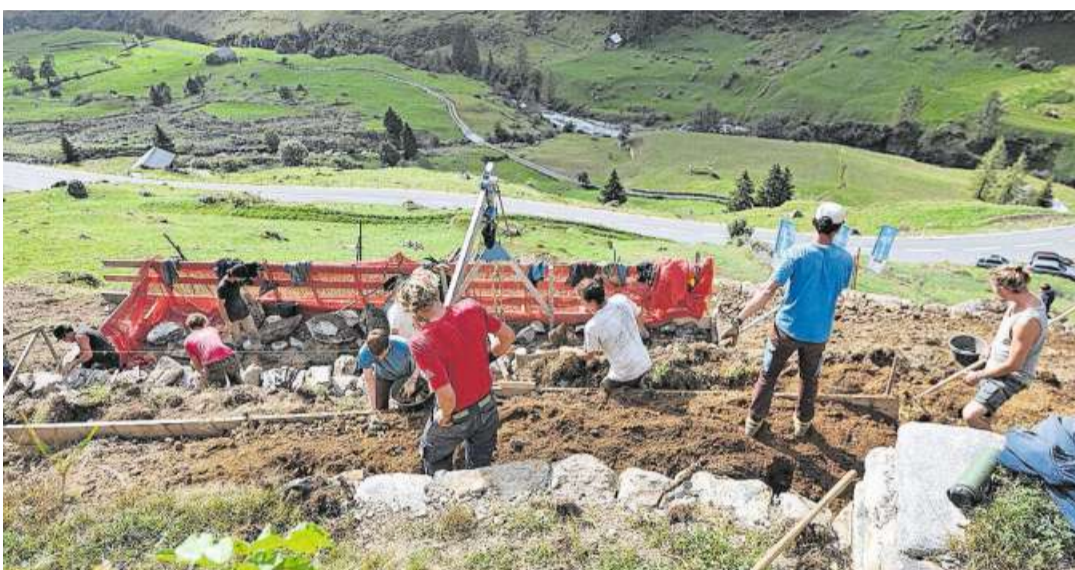
Zivildienstleistende sanieren bei Meien defekte Trockenmauern.
