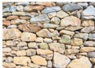
Eine Trockenmauer ist nur aus Steinen und ohne Hilfsmittel wie zum Beispiel Mörtel gefertigt.
