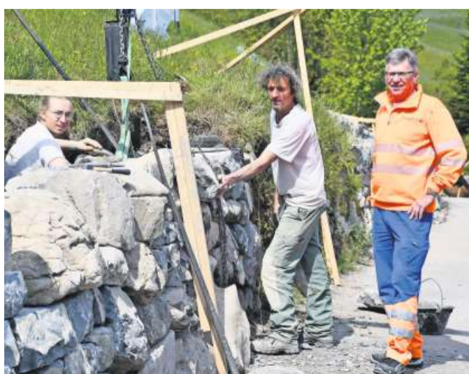
Werkmeister Alois Auf der Maur (rechts) und Markus Müller (Mitte), Spezialist für Trockenmauerbau, begutachten das Werk der «Zivis». Bild: Franz Steinegger
