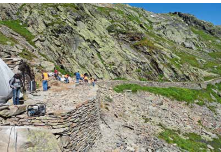
Travaux à 2500 m d'altitude: le chantier ne peut s'ouvrir que durant l'été.
