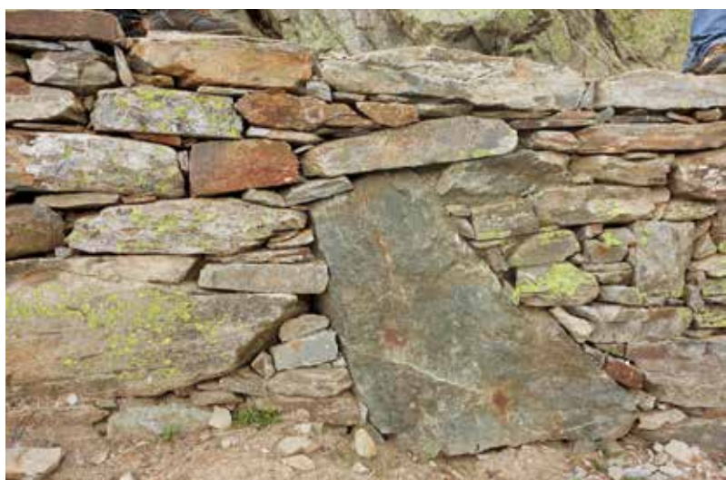
Le matériau est pris sur place, toutes les formes de pierre sont utilisées.
