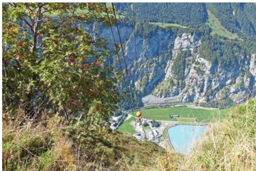
Blick von der Materialseilbahn aus ins Tal, auf einen Teil des Kraftwerks.
