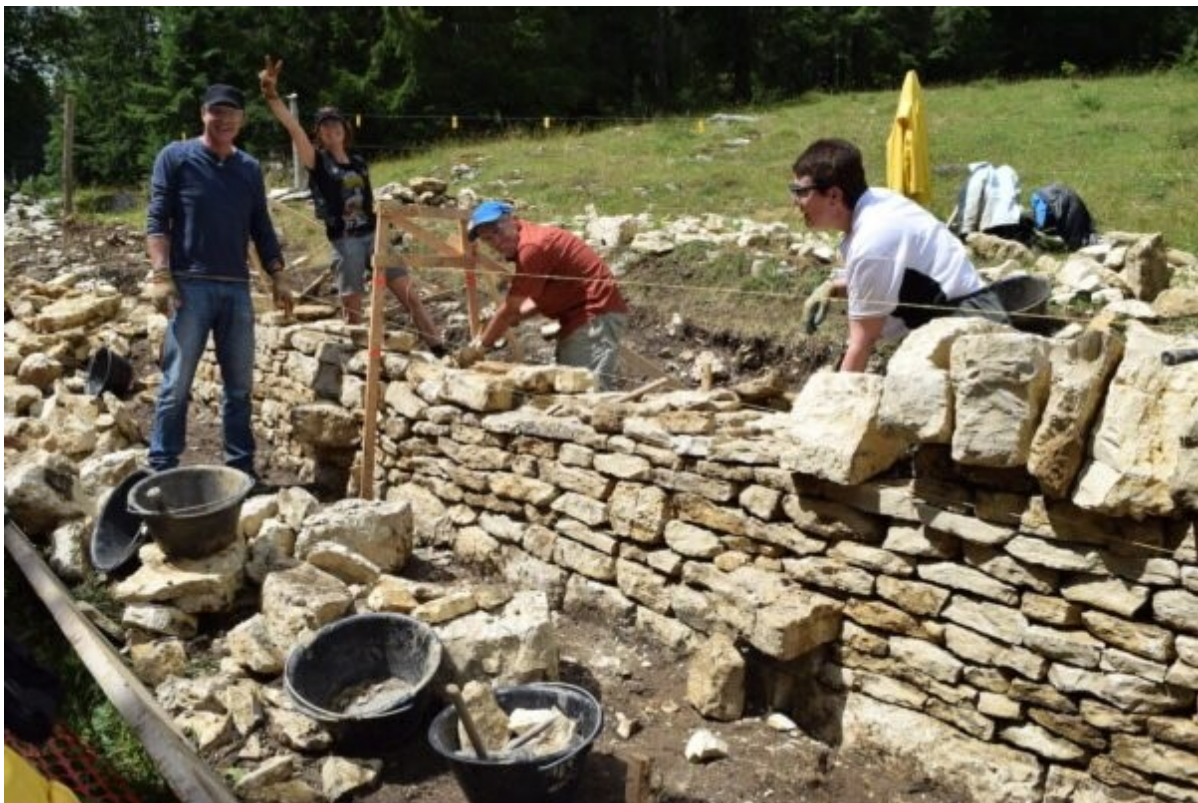
La Sagne NE: Wiederaufbau einer freistehenden Trockenmauer. © SUS
