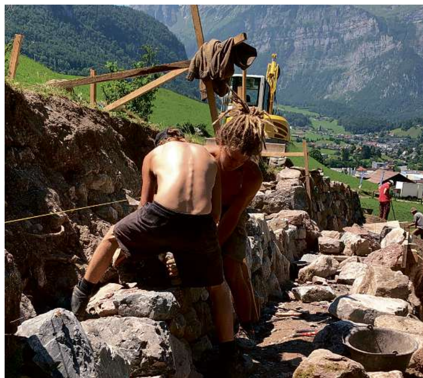
Kraftakt: Die Trockenmauern werden Stein für Stein wiederaufgebaut.
