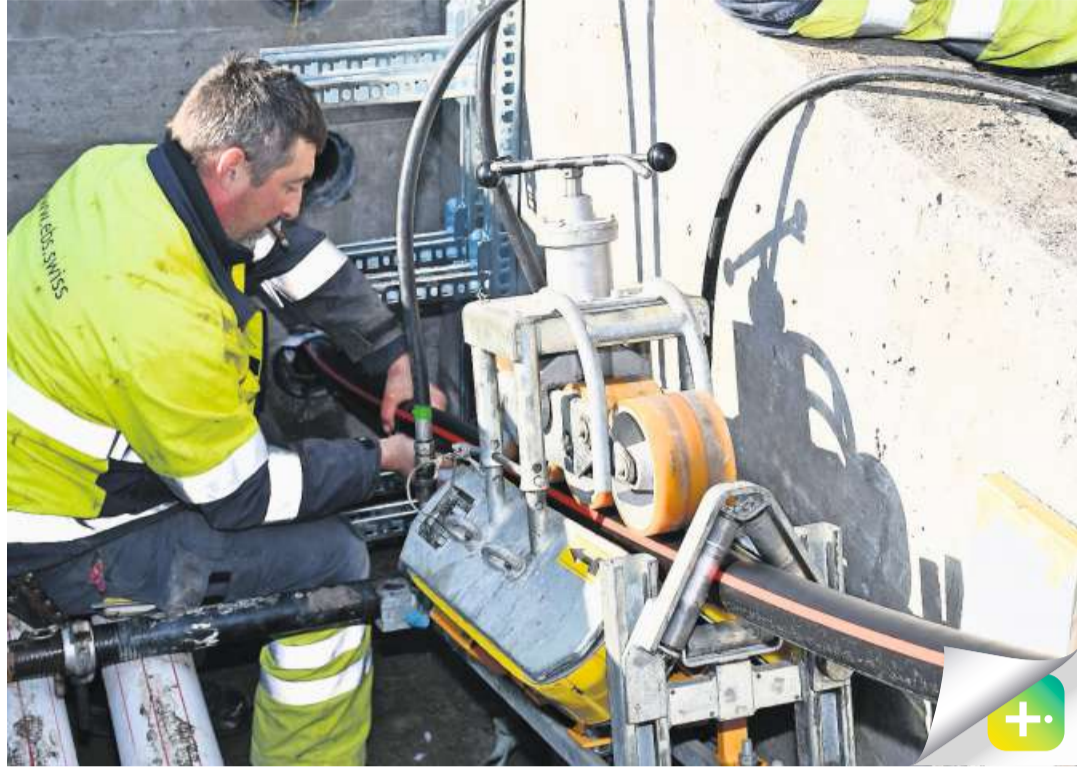
Wendelin Schelbert (links) zeigt das Kabel mit dem 5 cm 2 dicken Kupferherz, das 15 000 Volt leiten wird. Patrick Ulrich schmiert das Kabel beim Einführen in die erdverlegte Röhre, damit es besser gleitet. Der Kabelhund verleiht dem Einzugschub.
