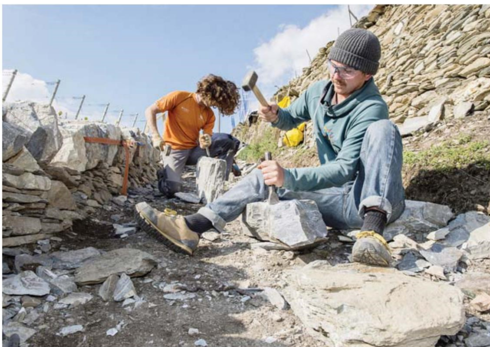
La saison des interventions de la Fondation Actions Environnement a été lancée à Martigny, avec la rénovation de murs de pierres sèches par des civilistes dans le vignoble situé à l'arrière du château de la Bâtiáz. HÉLOÏSE MARET
