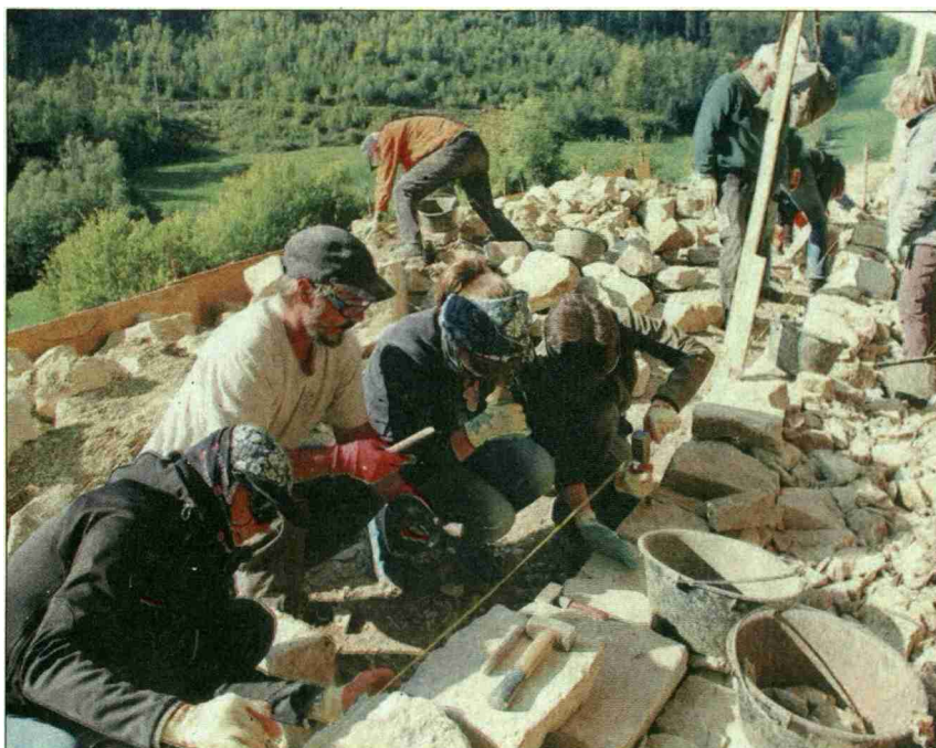
Trockenmauern: Kein einfaches Unterfangen
