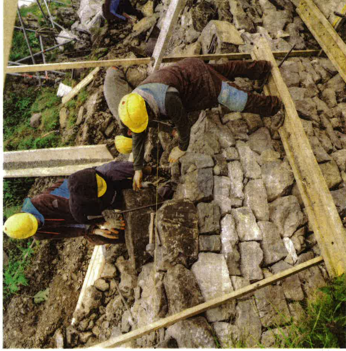
Stein, auf Stein, kleinere auf grössere – und auch umgekehrt. Die Schichtung erfolgte so, dass die Mauer mehrere hundert Jahre halten soll.
