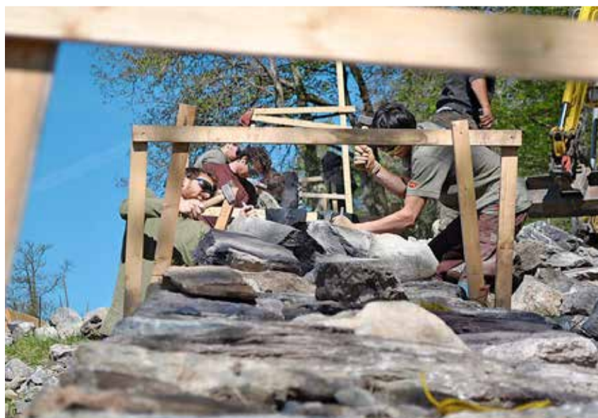
Eine Handwerkskunst: Für den Bau von Trockenmauern wird kein Mörtel benutzt. Umso exakter müssen die Handwerker arbeiten.
