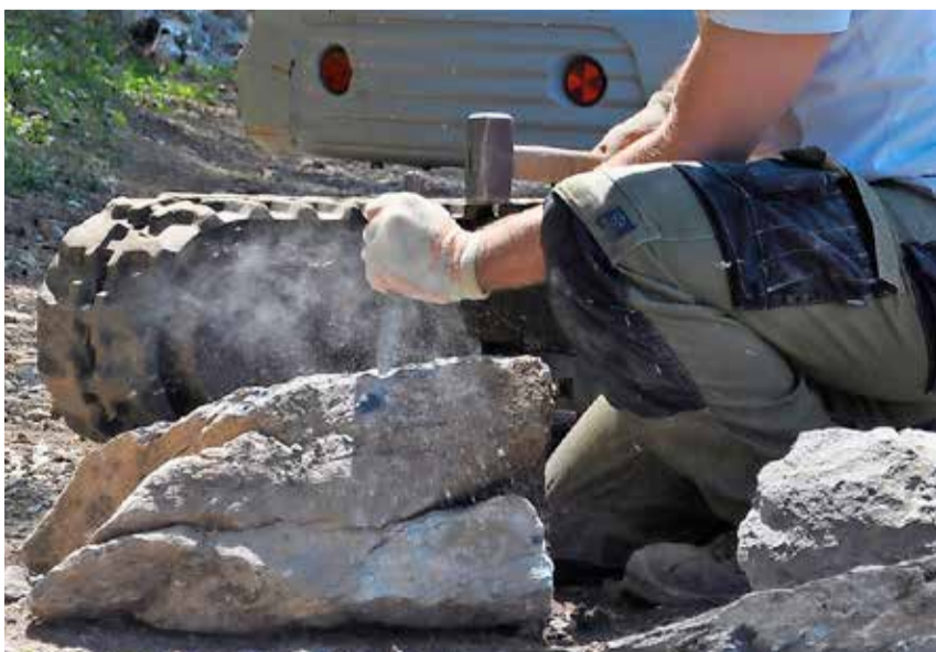
Strenge Arbeit: Bevor die grossen Steine in die Mauer eingereiht werden, müssen sie von Hand abgespitzt und in der Form angepasst werden.
