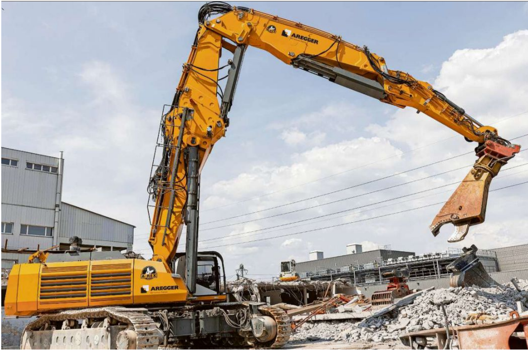
757 PS im Einsatz: Der A-Rex macht sich in Bilten an den Nebengebäuden zu schaffen, bevor die ehemalige Grossmetzgerei Kunz (links im Hintergrund) abgerissen wird. Bild Sasi Subramaniam
