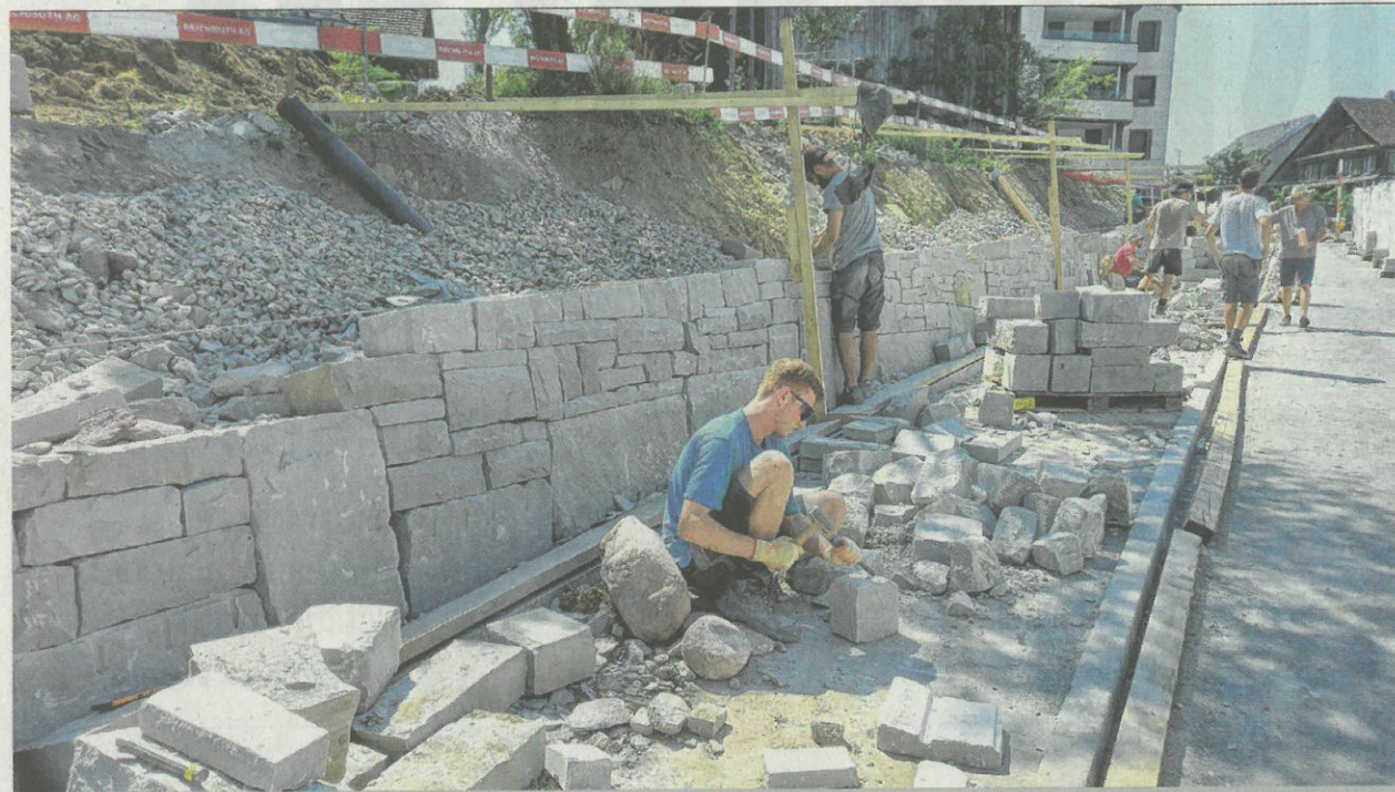
Für die sich im Bau befindende Trockenmauer braucht es rund 150 Tonnen Steine. Rund ein Dutzend junge Männer des schweizerischen Zivildienstes sind auch im Einsatz.
