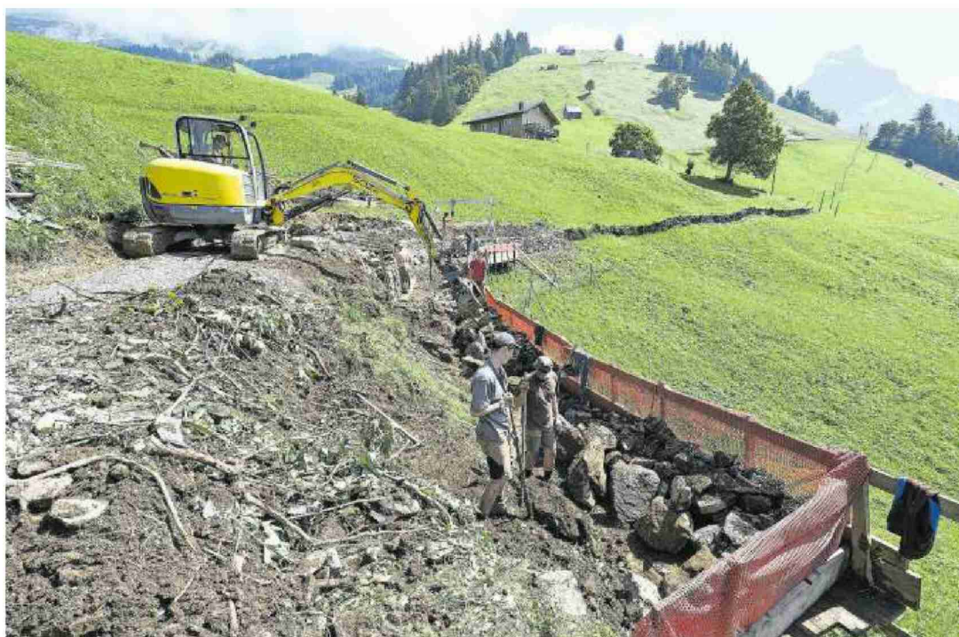
Die Arbeiten an den Trockensteinmauern in Engelberg kommen voran.
