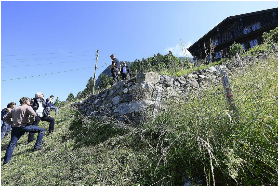
Eine 2017 fertiggestellte Trockenmauer im Gebiet Schwand, Engelberg. (Bild: Christof Hirtler)
