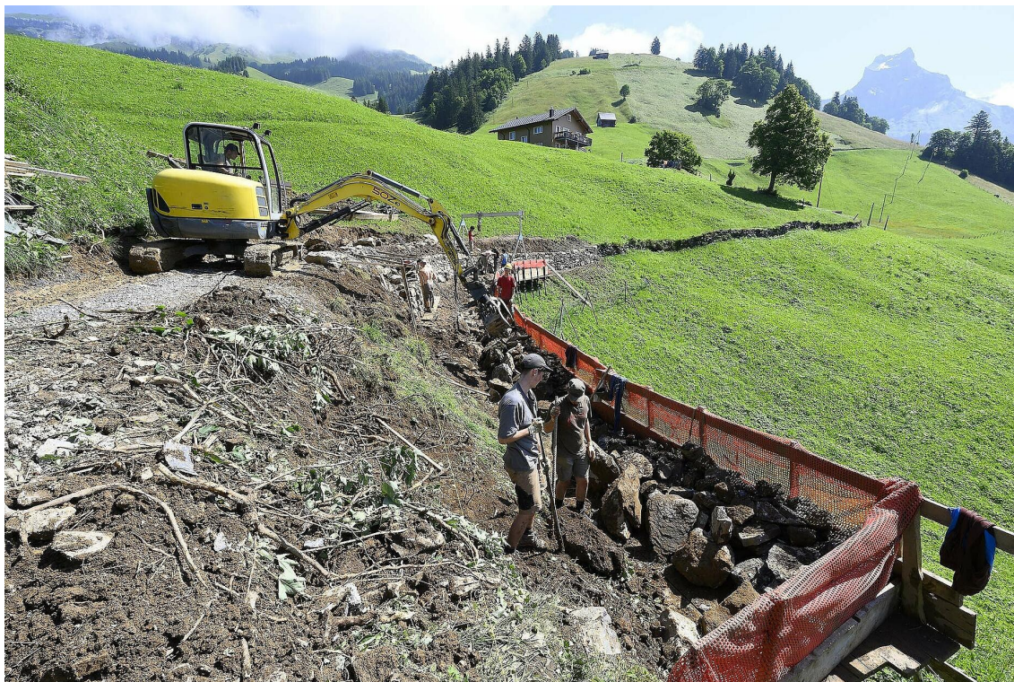
In Engelberg sanieren Zivildienstleistende in aufwendiger Handarbeit eine Trockenmauer im Gebiet Bärgli. Vorne im Bild die Arbeitsbühne. (Bild: Christof Hirtler)
