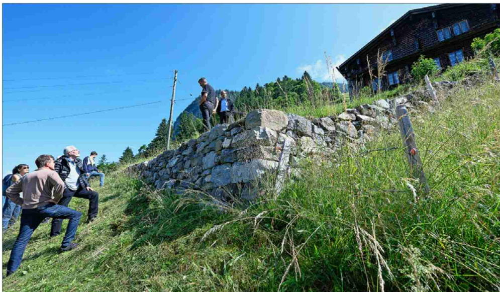
Eine 2017 fertiggestellte Trockenmauer im Gebiet Schwand OW. (Bild: Christof Hirtler)
