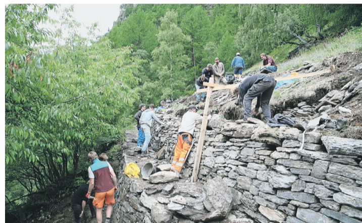
15 Zivildienstleistende standen in den letzten sechs Wochen für die Sanierung der Trockenmauern am Kapellenweg in Randa im Einsatz.
