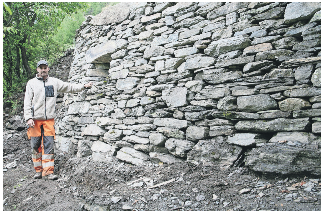
Pascal Zobrist vor einer der neu erstellten Trockenmauern samt Schnapsloch am Kapellenweg in Randa. Bilder: pomona.media
