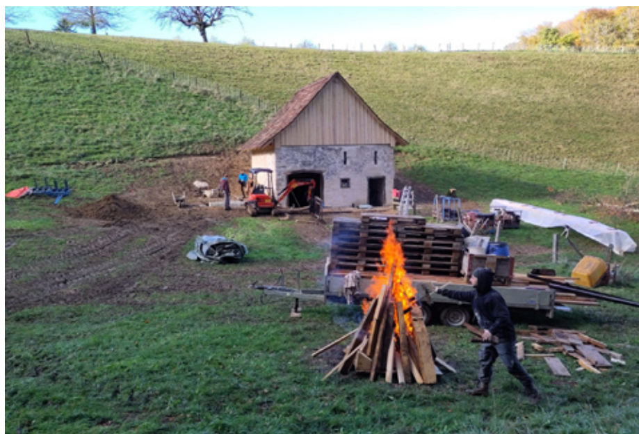
Rénovation d'une grange de campagne à Ziefen.
