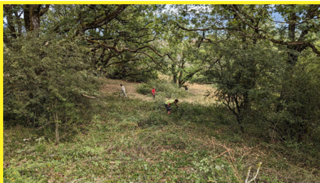
Travaux de débroussaillage dans la PPS de La Chassagne, Onnens.
