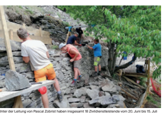
Unter der Leitung von Pascal Zorist haben insgesamt 18 Zivildienstleistende vom 20. Juni bis 15. Juli 70 Quadratmeter stark beschädigte Trockenmauern in Randa saniert.
