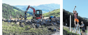
Die die Nagelfluhbrücken für die Trockenmauer zu befestigen, ist sehr schwierig. Bild: 202
