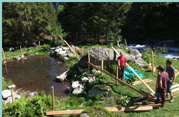
Installation de clôtures autour d'un étang pour amphibiens à Andermatt.
