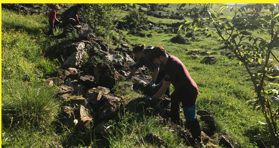
Reconstruction d'anciens murs de pierres sèches dans l'Urnerboden.
