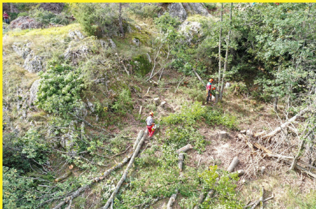
Travaux de bûcheronnage, PPS Sur-le-Mont près de Martigny.
