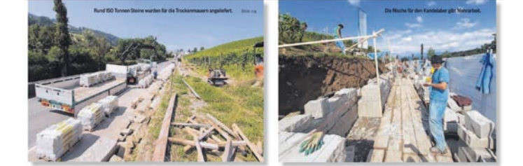
Rund 500 Tonnen Steine werden für die Trockenmauern angefordert. (Bild: FAE)
